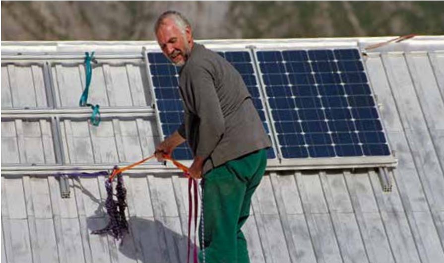
Jürgen Gutekunst im Element – Solarinstallation auf dem Dach der Simmshütte
